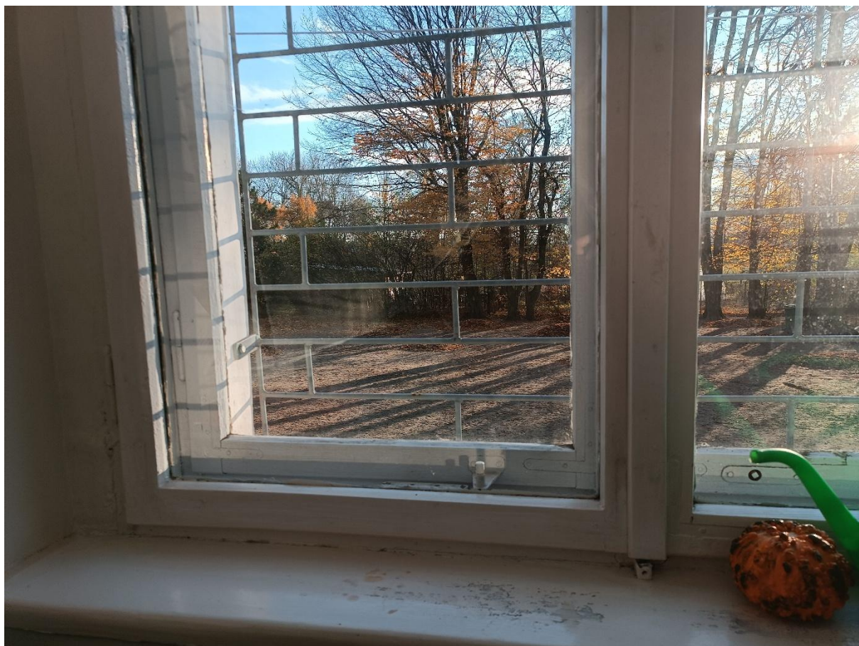
Rysunek 14 Widok okna drewnianego skrzynkowego zastosowanego w budynku
